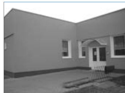
Fasáda u vstupu po dokončení
