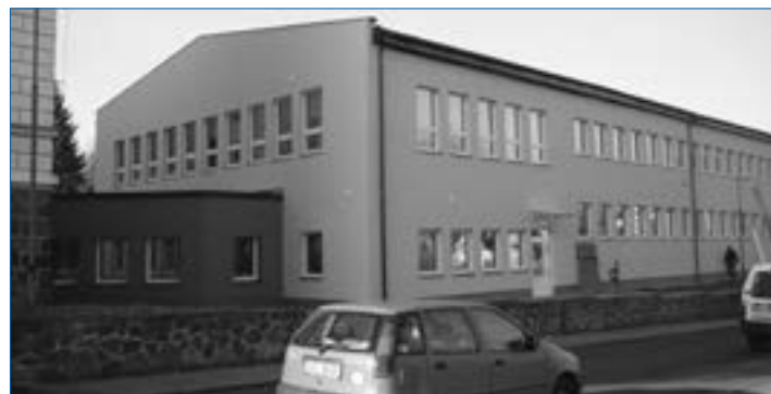
Fasáda po dokončení
