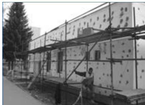
Fasáda po instalaci zateplení
