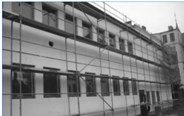
Instalace kontaktního zatepl. systému
