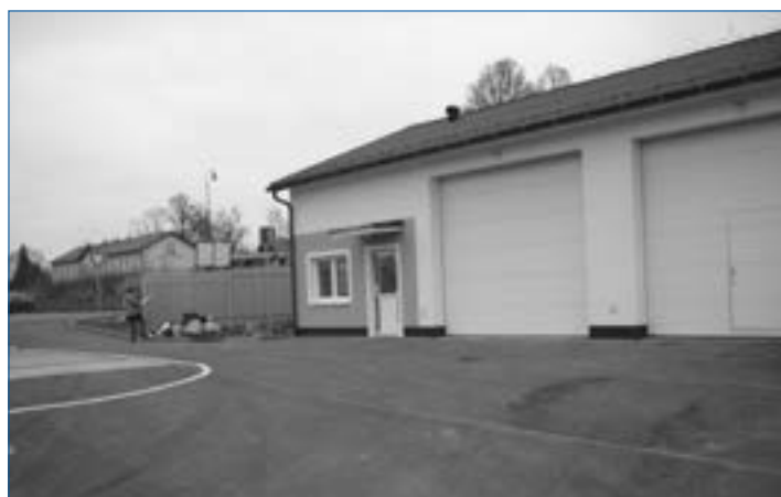
Vjezd, váha a administrativní budova s garážemi
