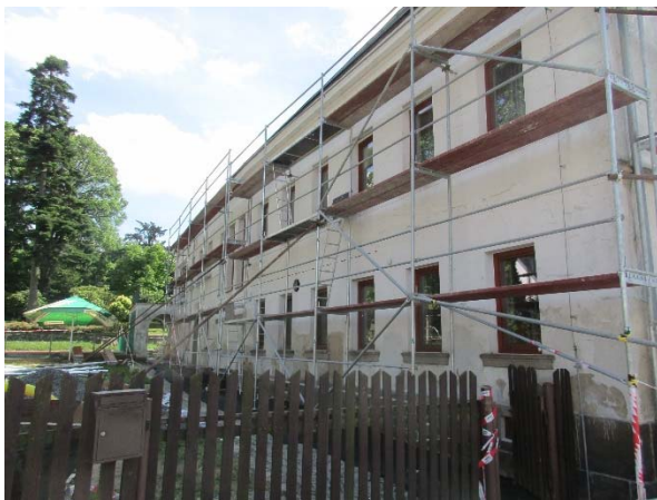
připravené lešení pro obnovu fasády
