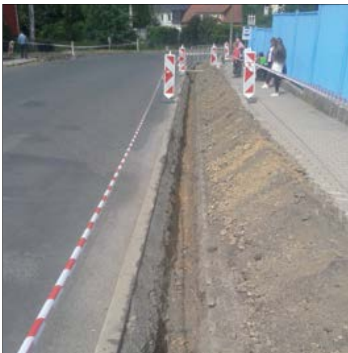
příprava na pokládku kabelu veřejného osvětlení
