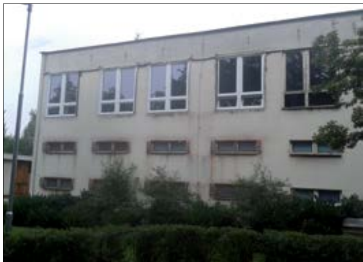
pohled na nově osazená okna
