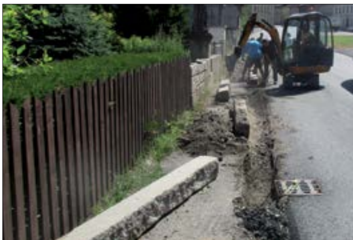
pokládka obrubníku rozšířeného chodníku
