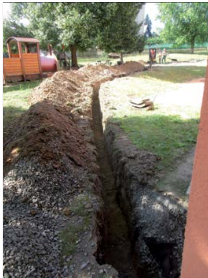
výkop vodovodní přípojky pro pítka v zahradě MŠ
