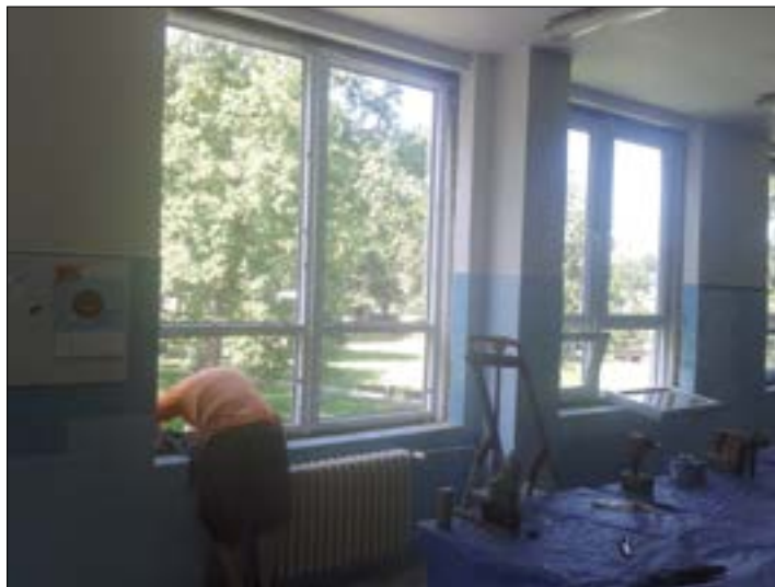
instalace nových oken jídelny
