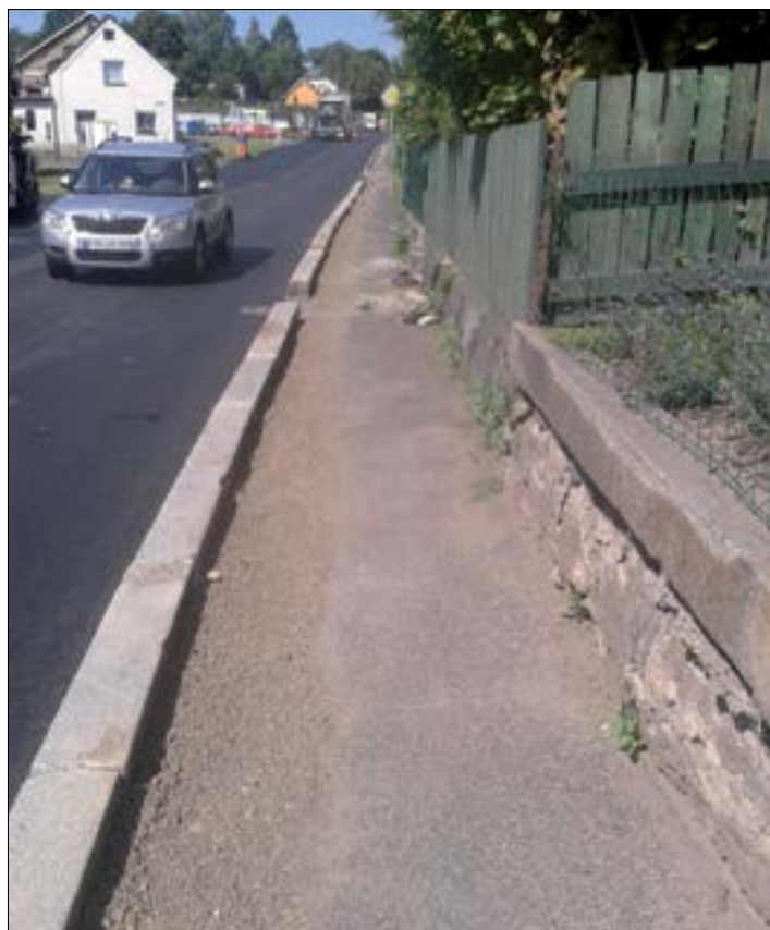
rozšířený chodník s provizorním dosypáním
