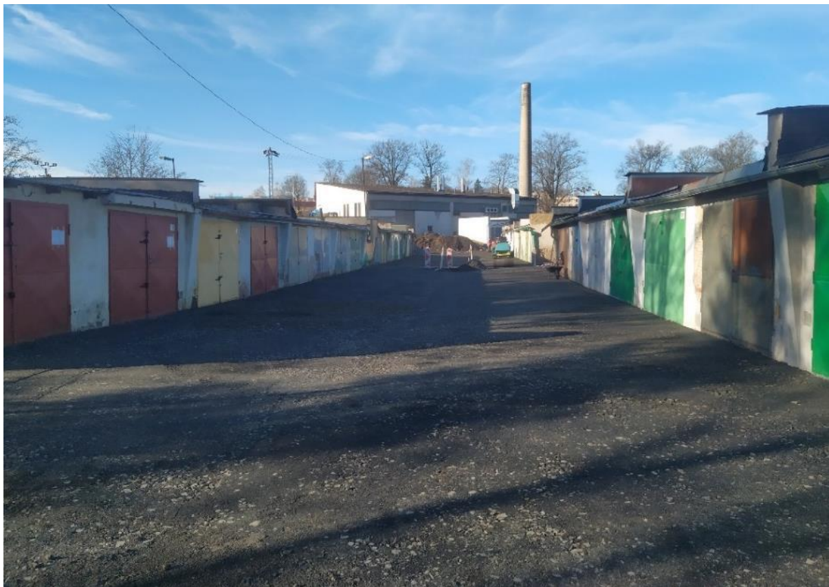
Vyšťerkované plochy mezi garážemi
