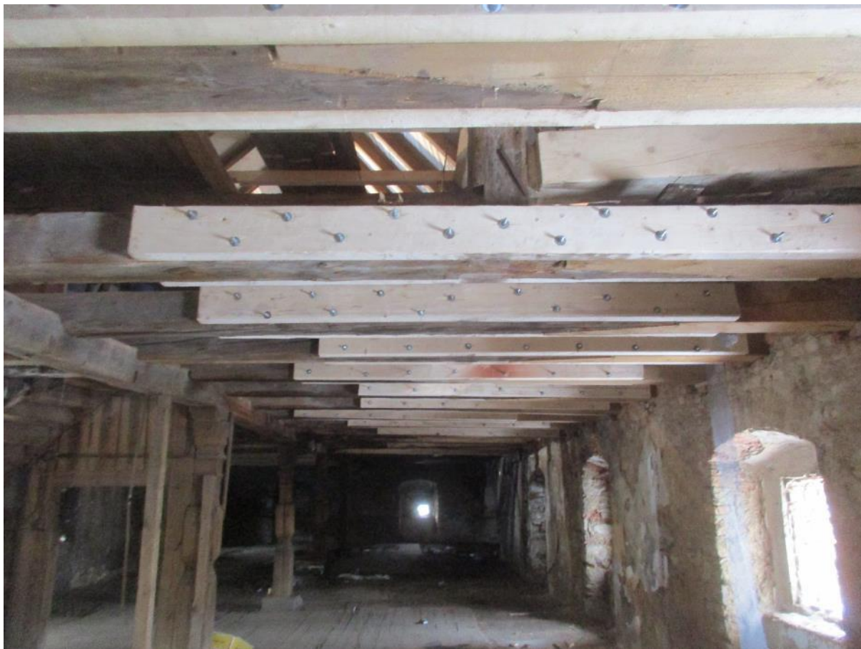
opracován, vyztužení a doplnění stropních trámů nad 2. NP
