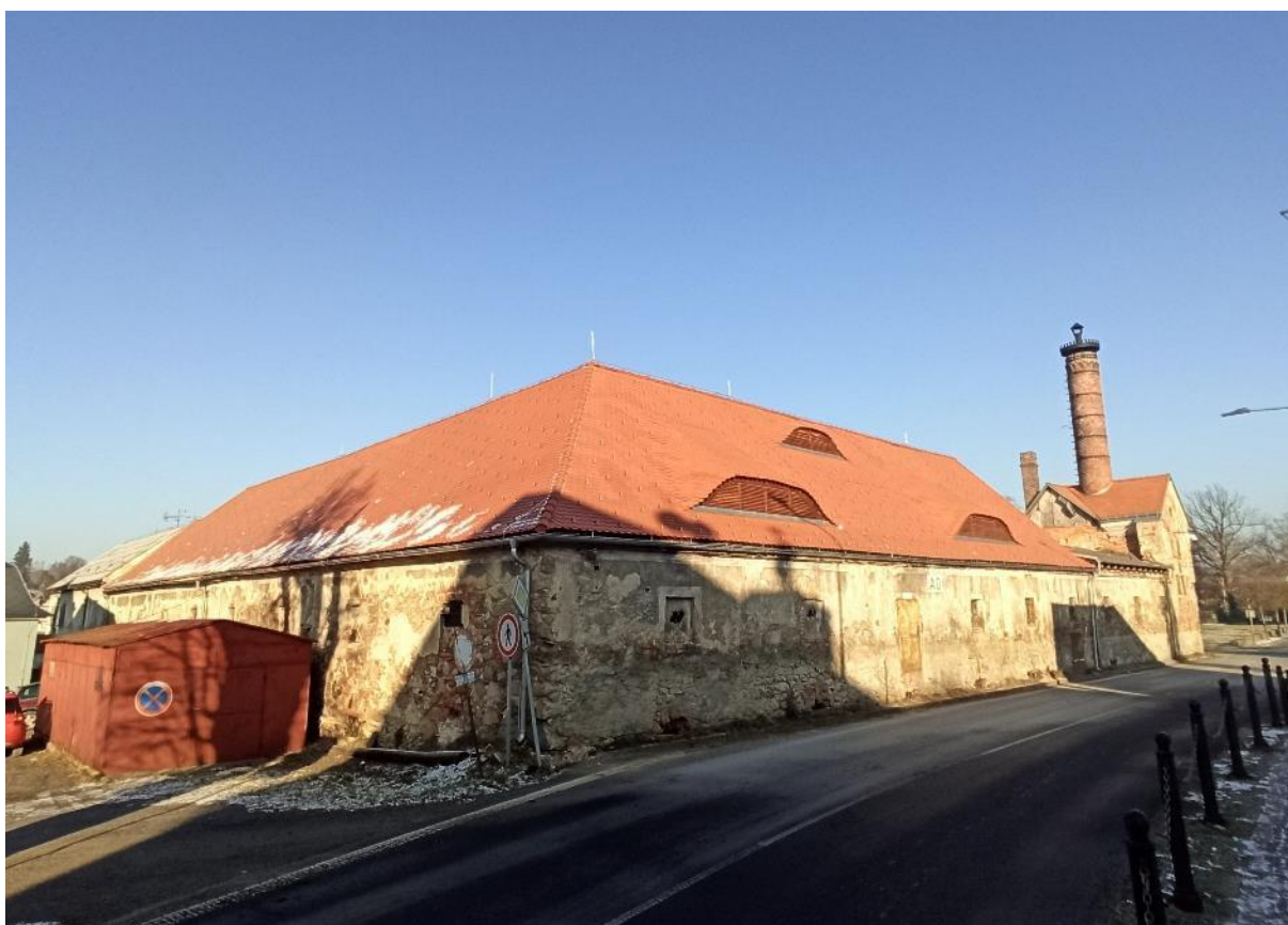
dokončená 3. etapa opravy krovy a střechy objektu sladovny
