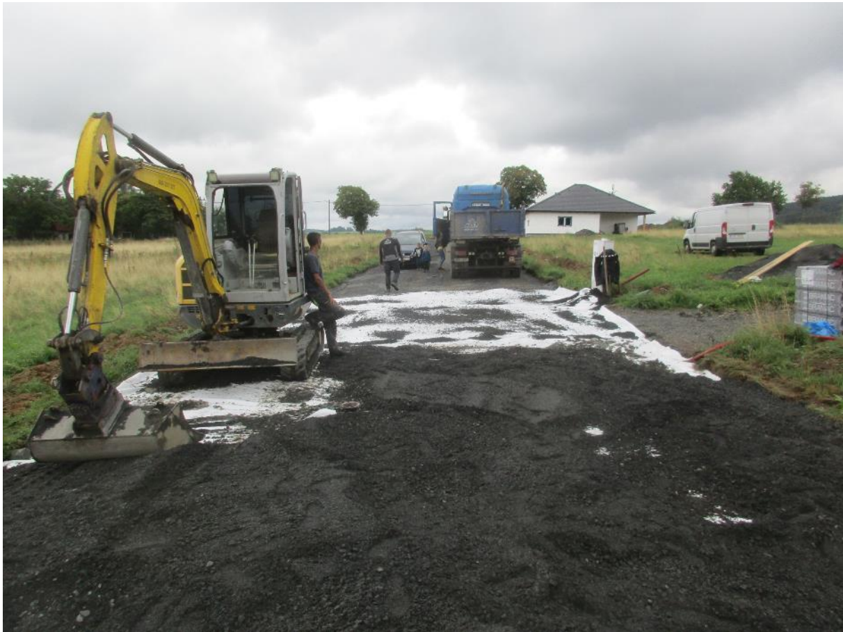
pokládka pojízdné, dočasné vrstvy štěrku na separační geotextílii oddělující spodní vrstvy
