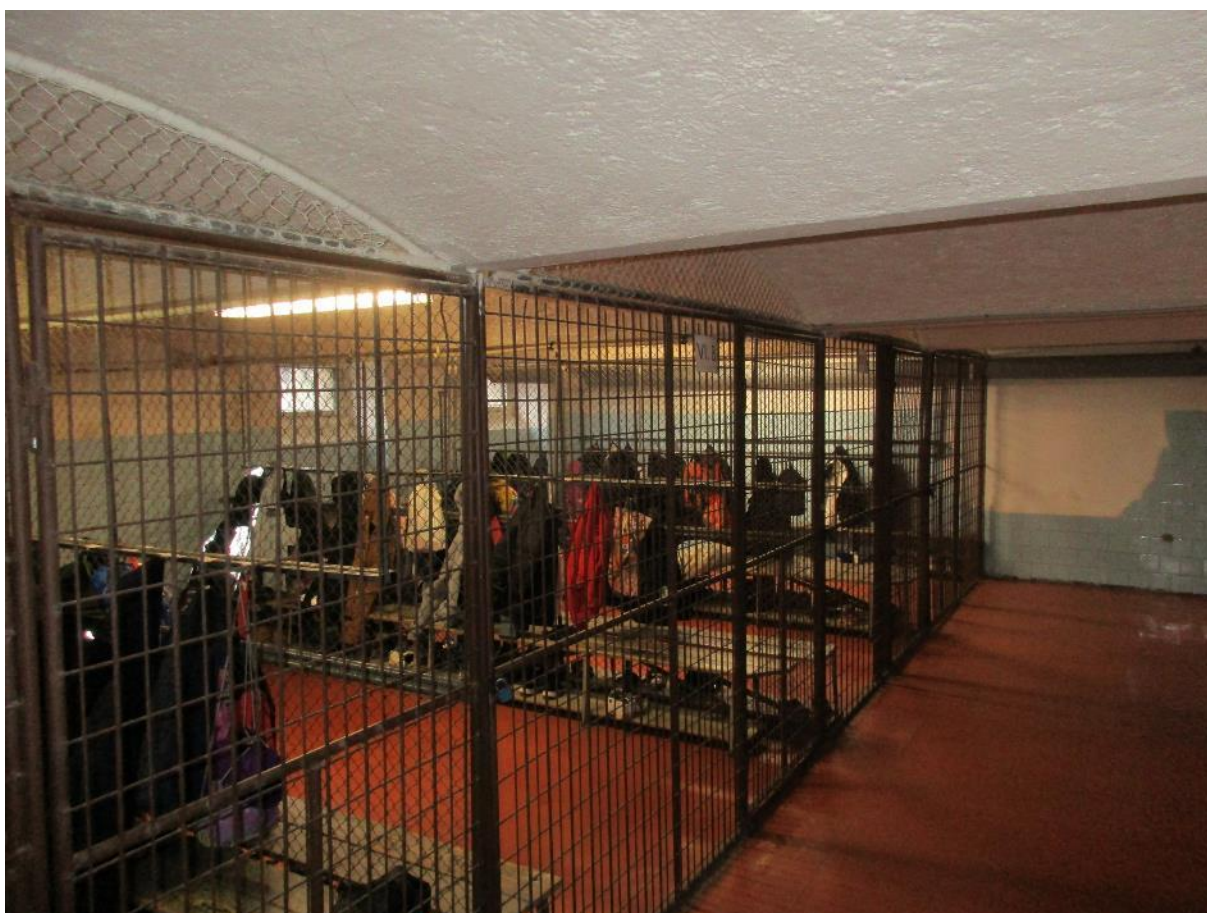
původní stav prostoru šaten a šatních kójí
