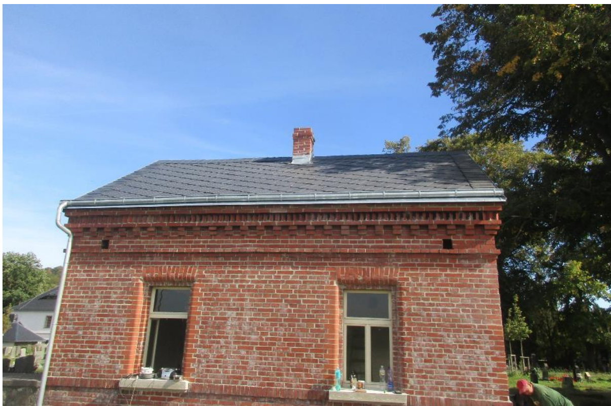
dokončená výměna střešní krytiny, oken a klempířských prvků – jižní pohled
