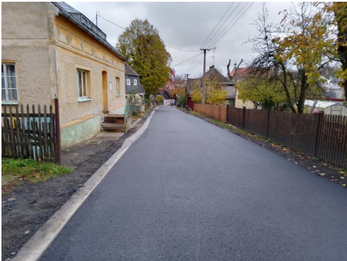
ulice s položeným asfaltem a novými obrubníky
