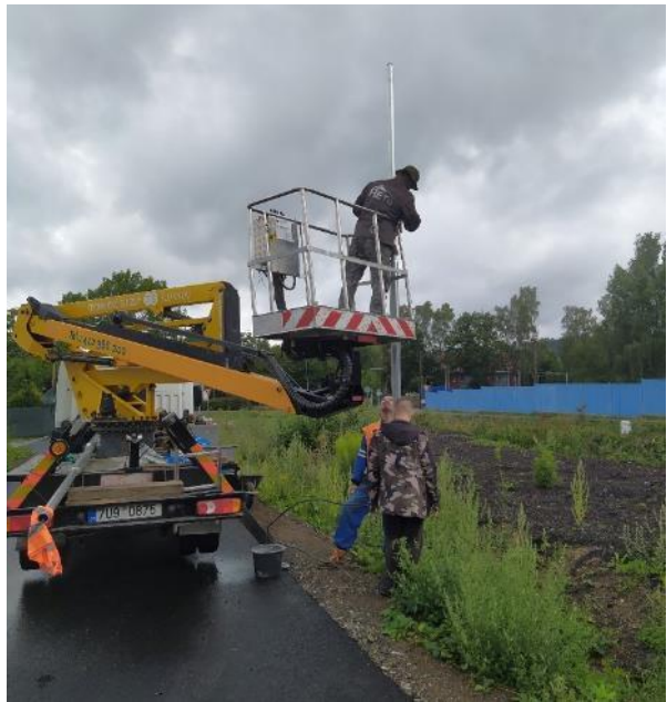
Osazování nových lamp
