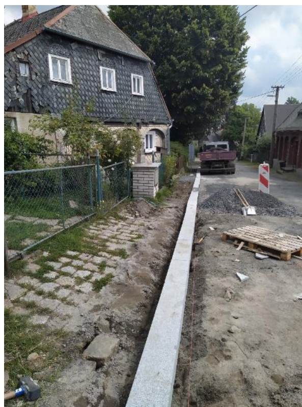
pokládka kamenných obrubníků
