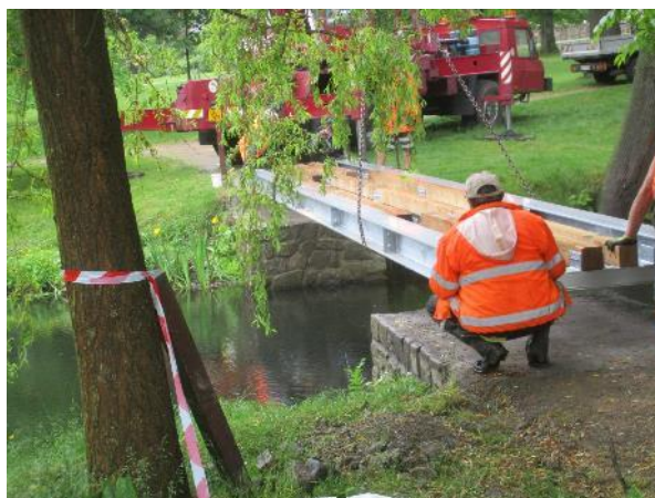
ukládání nové mostovky lávky
