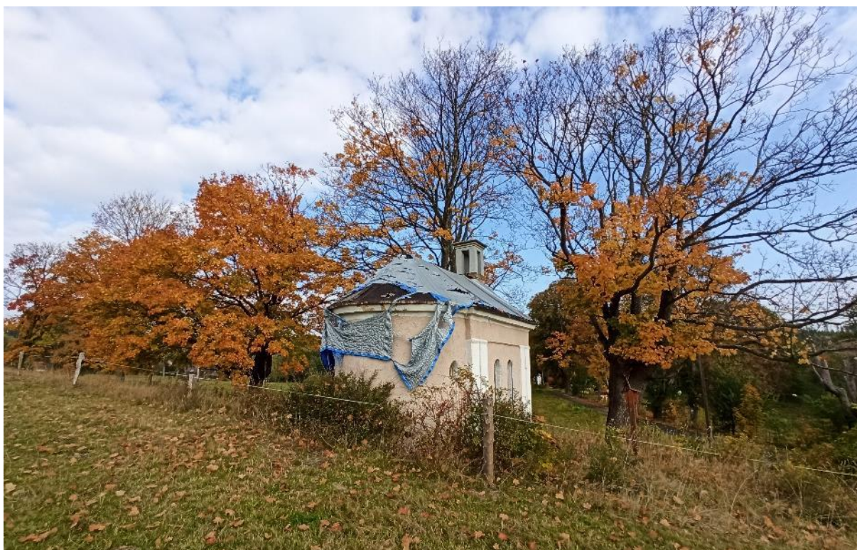
původní stav střechy kapličky 2022
