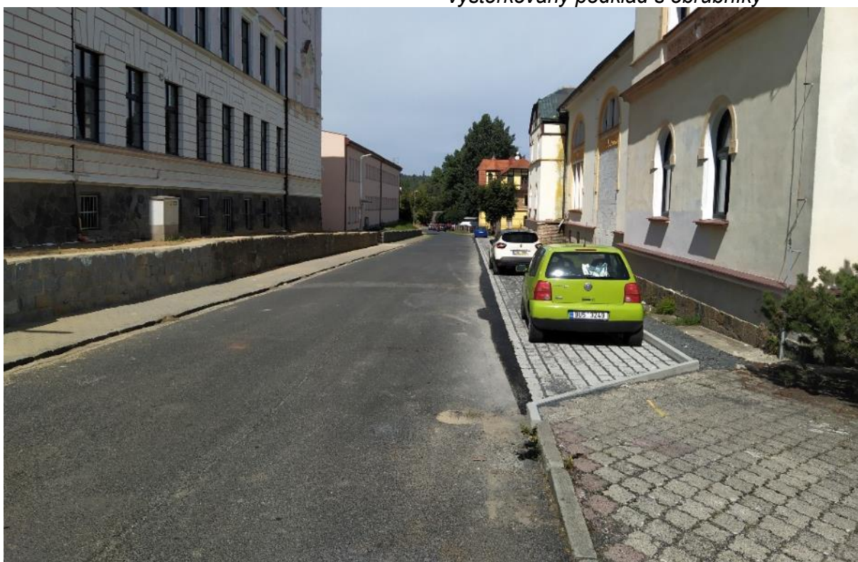
dokončený záliv s prvními parkujícími
