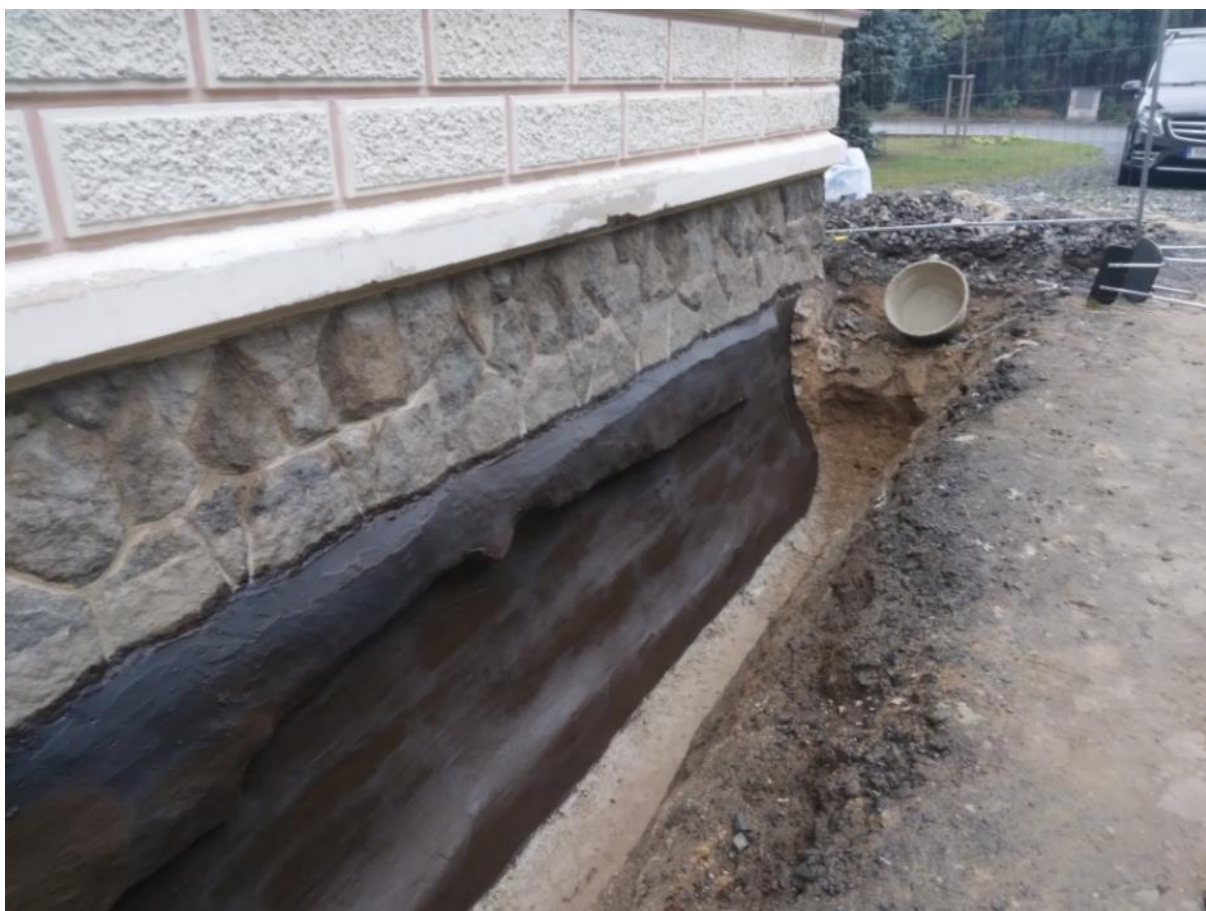
provádění odizolování objektu
