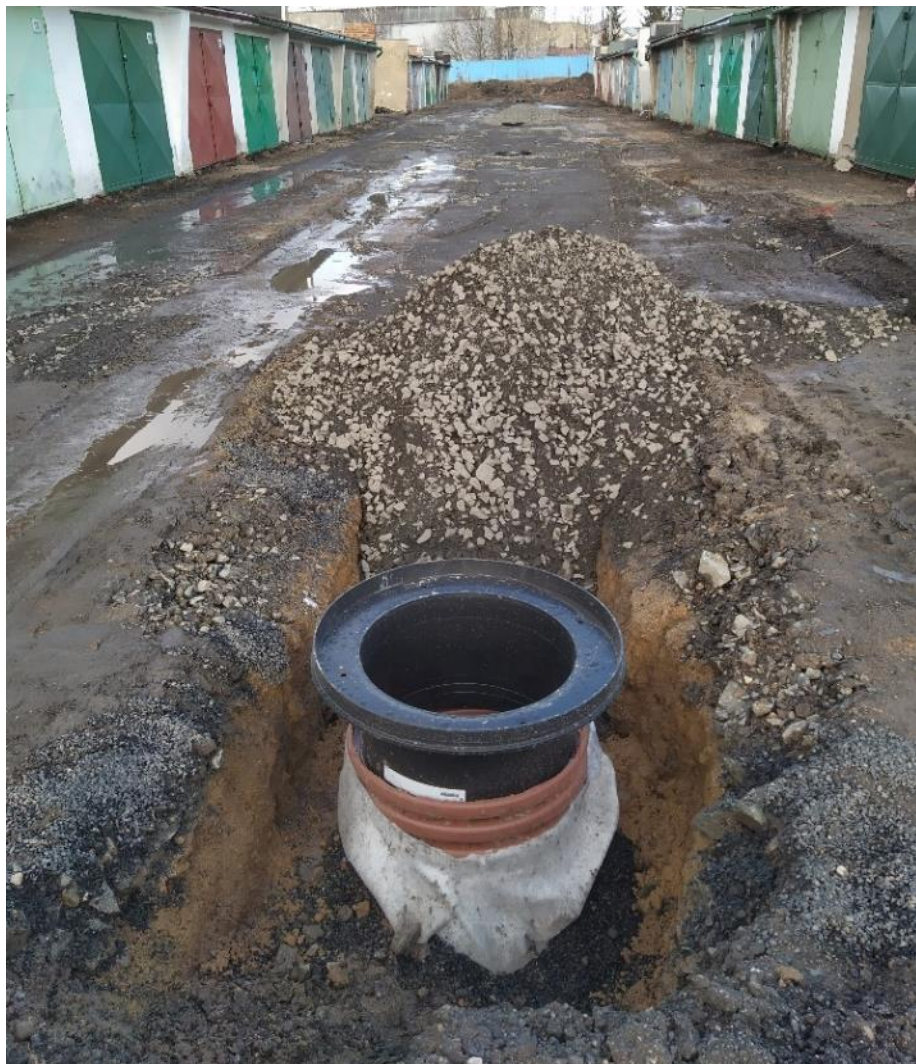
Pokládka vsakovacích galerií
