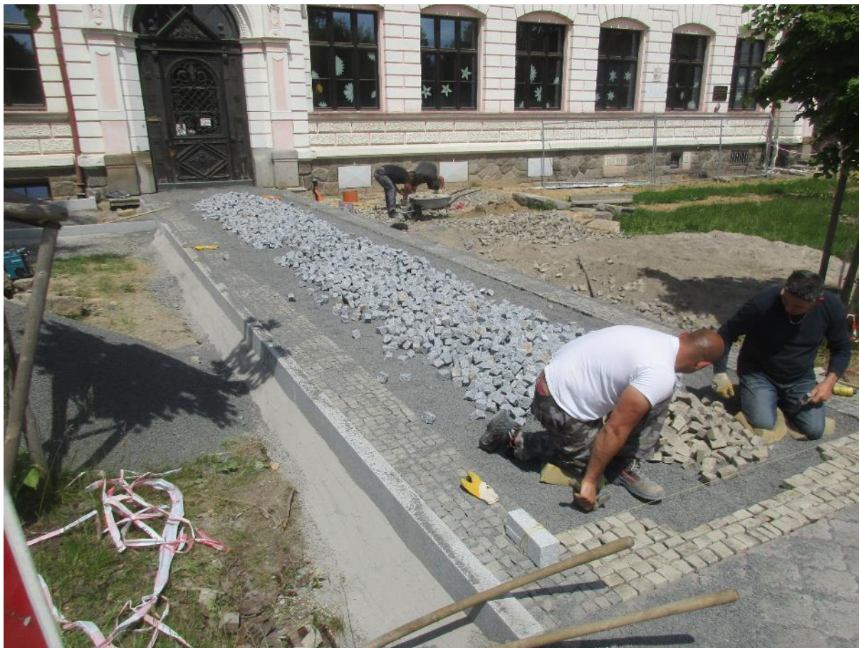
dláždění bezbariérového přístupu do ZŠ
