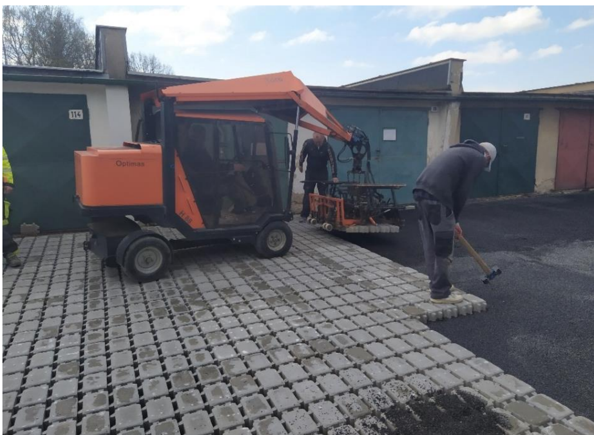
Pokládka zatravnovací dlažby
