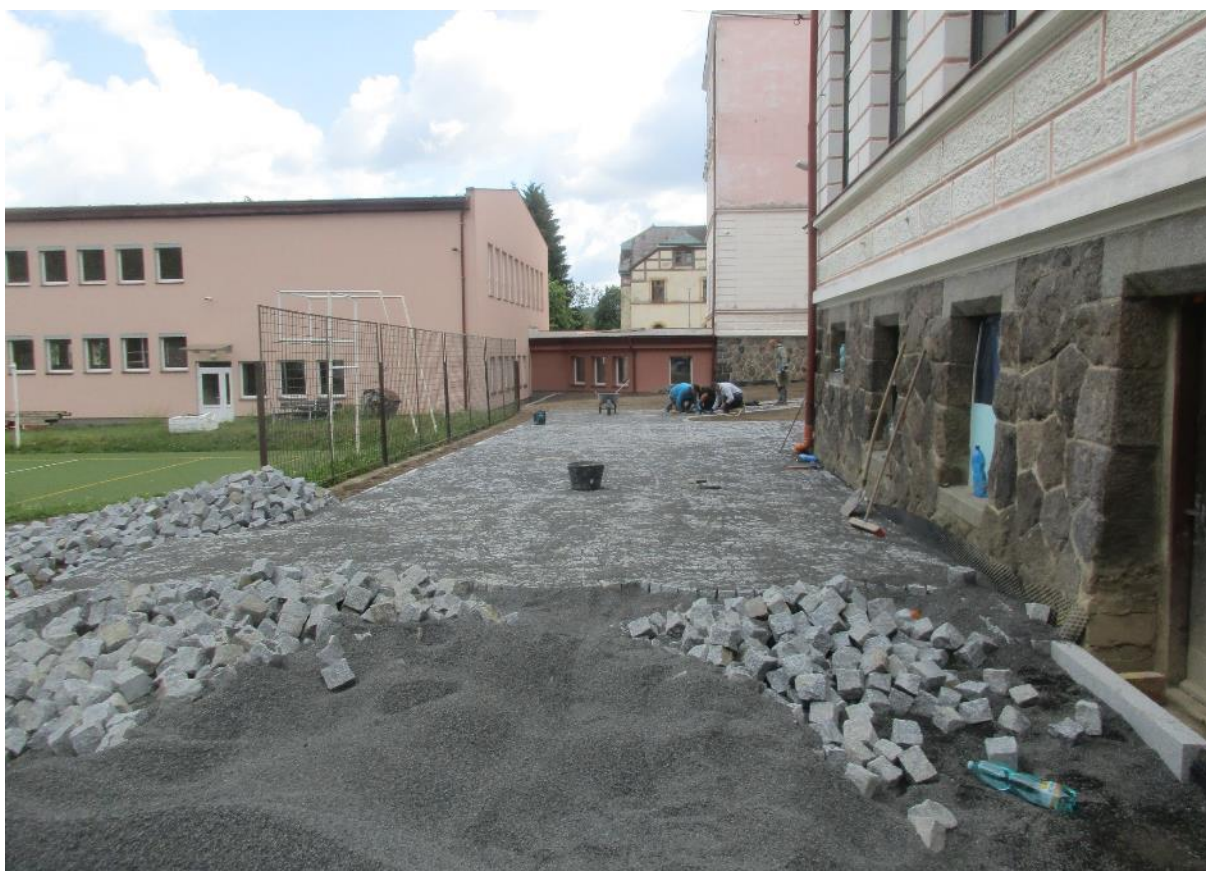
provádění dlažeb po dokončených hydroizolacích objektu
