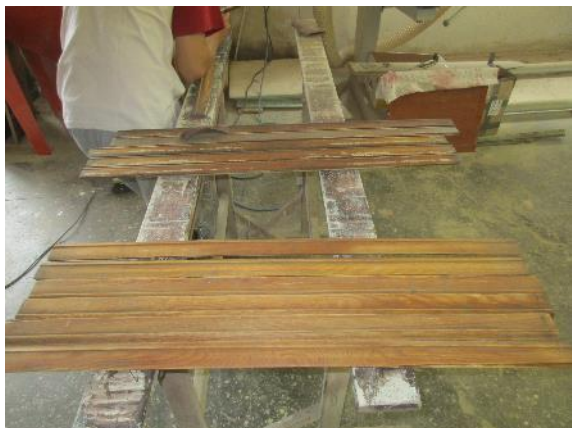
repase původní dřevěné žaluzie
