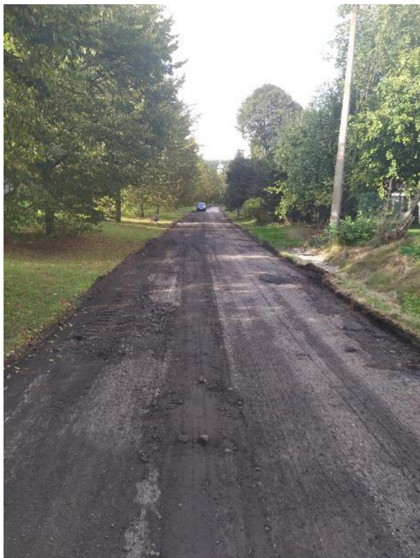
ulice při zahájení prací po vyfrézování
