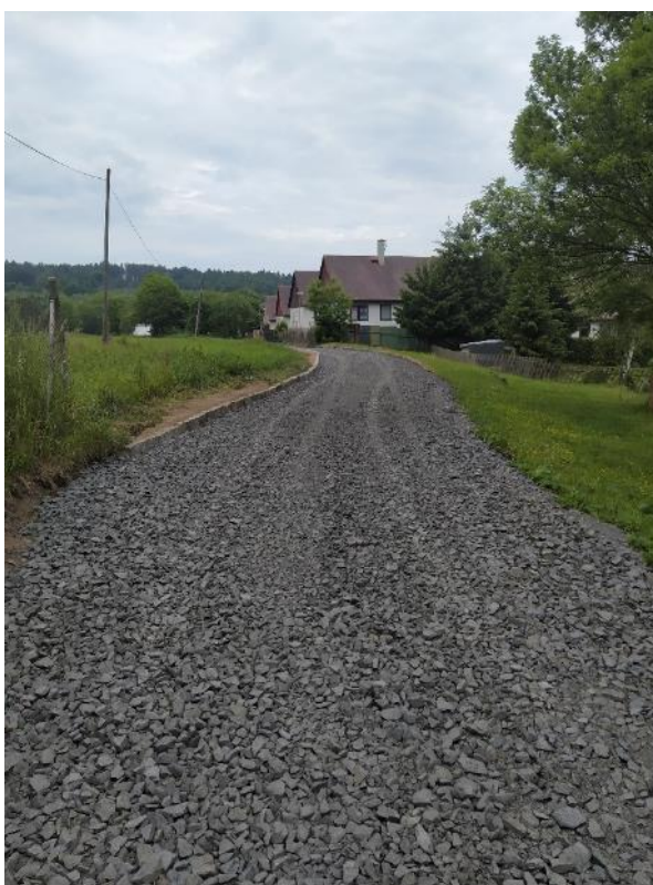
štěrkování podkladu v Sukově ulici
