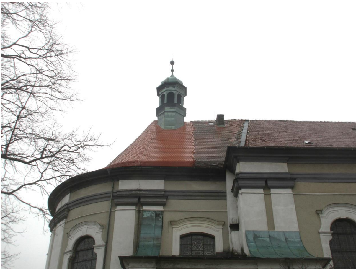
část střechy apsidy kostela sv. Václava
