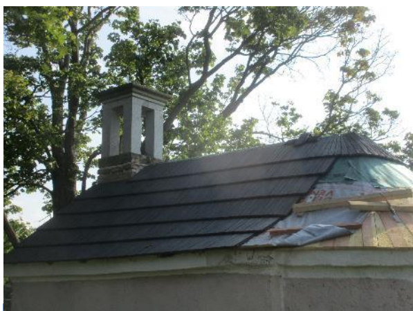
pokládka umělého šindele
