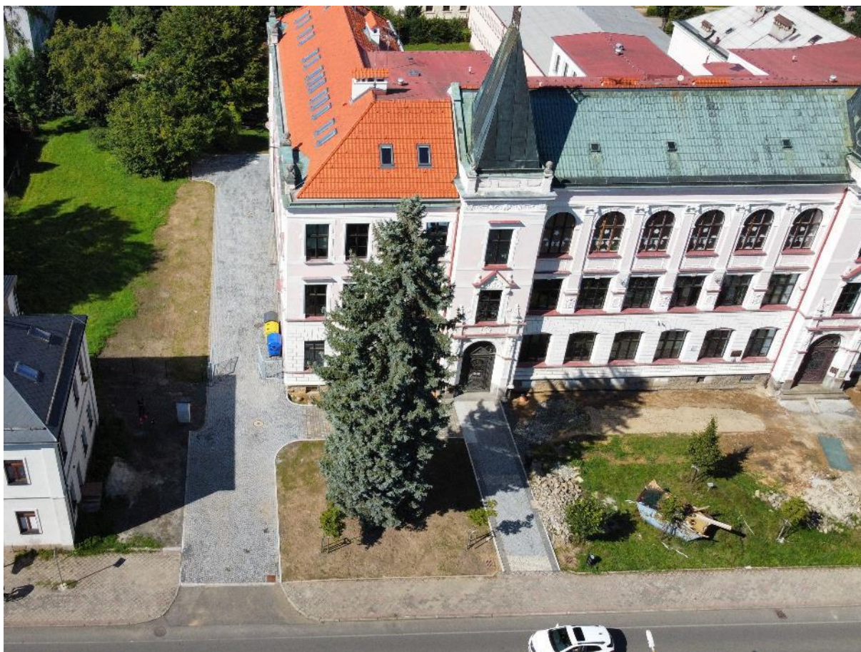
dokončené dláždění levé přední části u ZŠ a průchod na nádvoří a k jídelně
