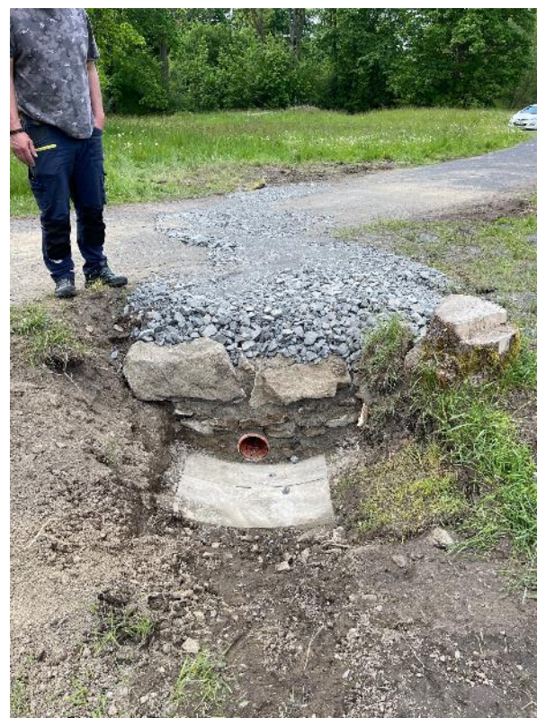
a po opravě...
