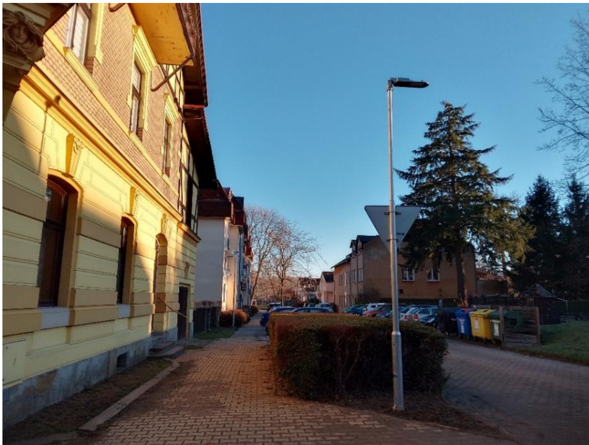
Nová svítidla s opraveným chodníkem
