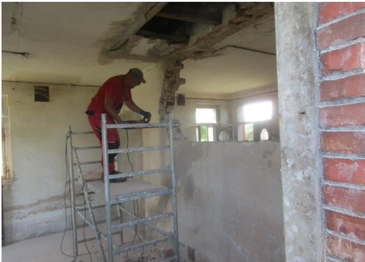
bourání středové zdi v objektu
