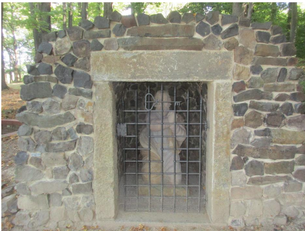
osazení mříže a restaurované sochy sv. Petra
