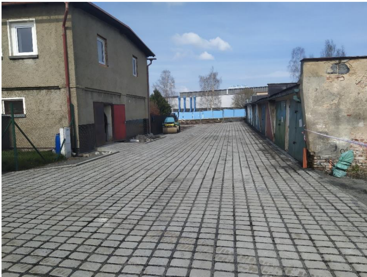
Hotová zatravnňovací dlažba v ploše PG4
