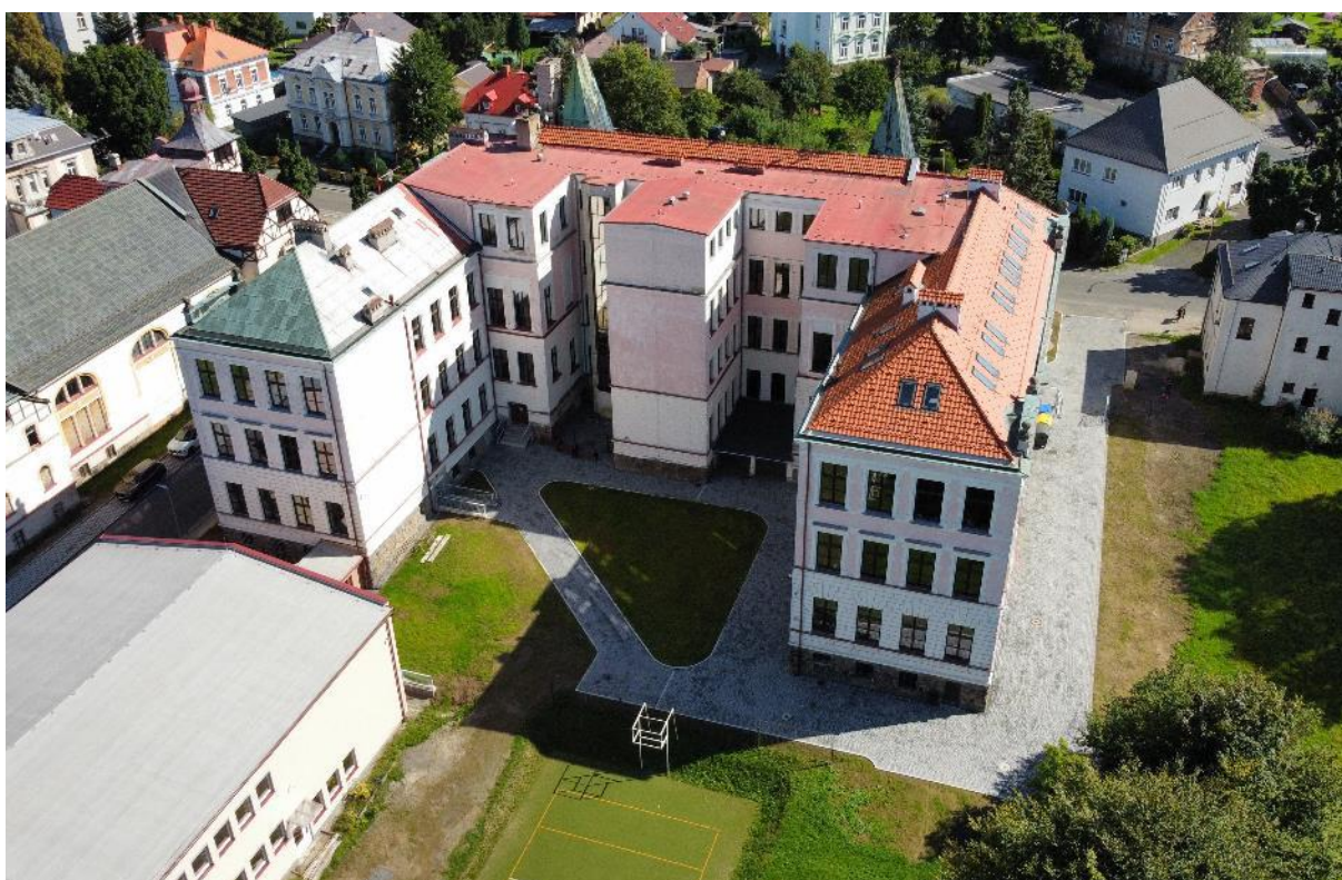
dokončené dláždění plochy dvora a přístupu od hlavní brány
