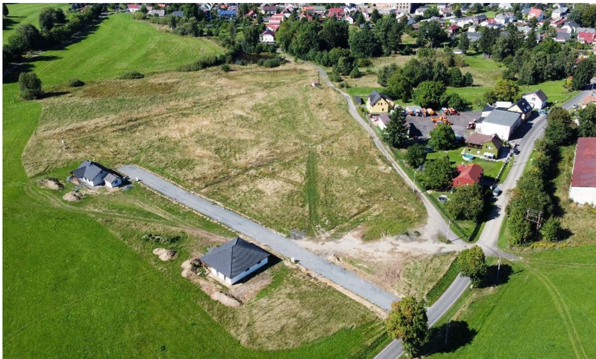
část trasy A po dokončení (zatím bez asfaltového povrchu)
