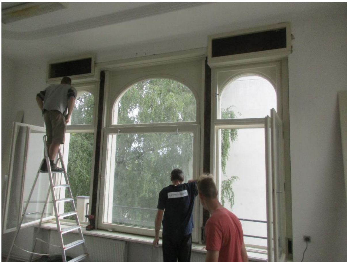
repase 3dílného okna ve 2. NP
