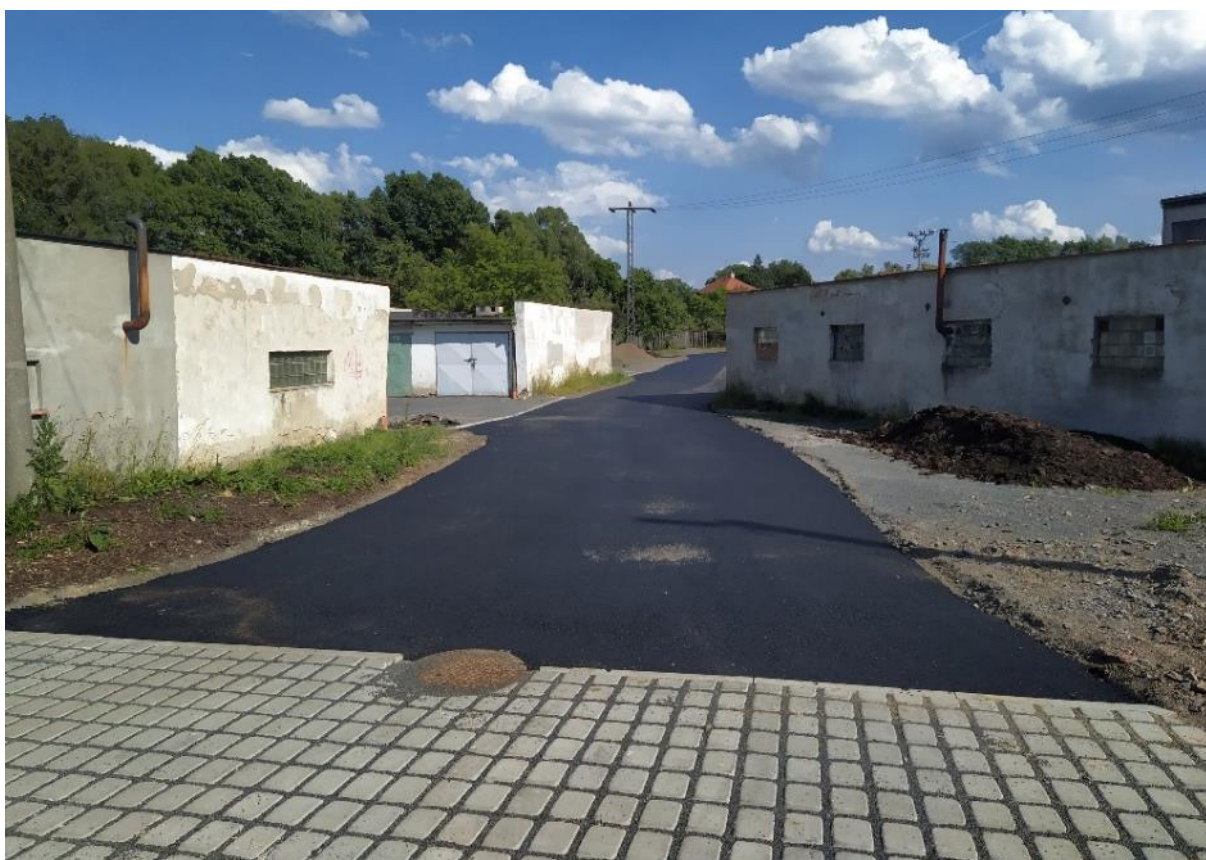
Vyasfaltované příjezdové komunikace
