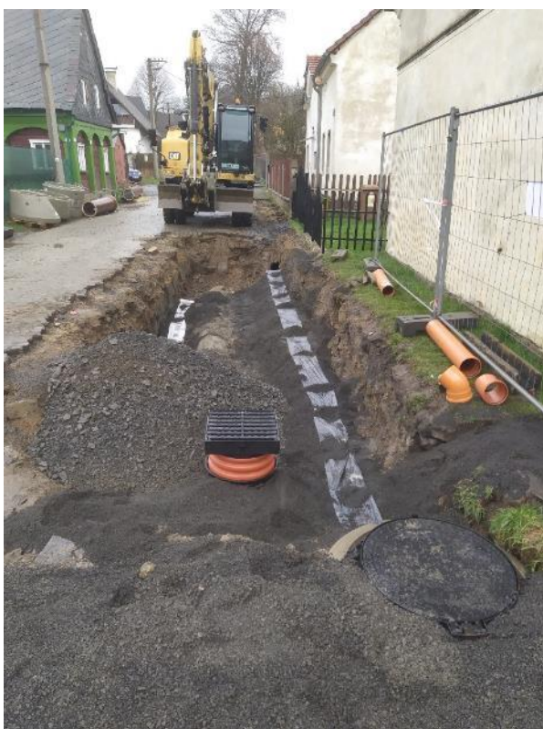
souběh kanalizačních tras pod chodníkem
