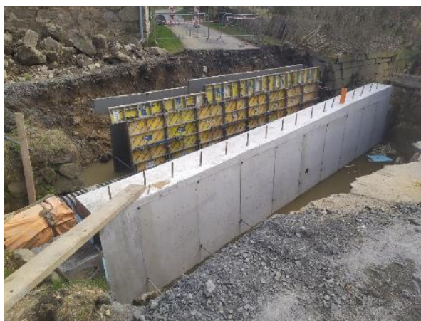
jeden z pův. kamenných mostků, bez zábradlí opěry nového mostu v realizaci
