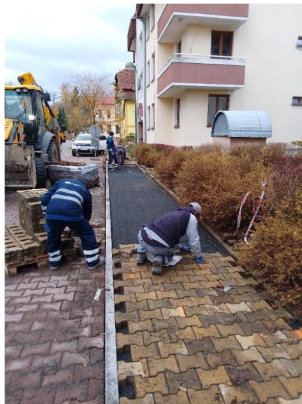
Pokládka dlažby opraveného chodníku
