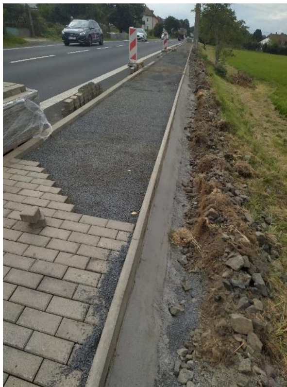
stabilizace obrubníku chodníku
