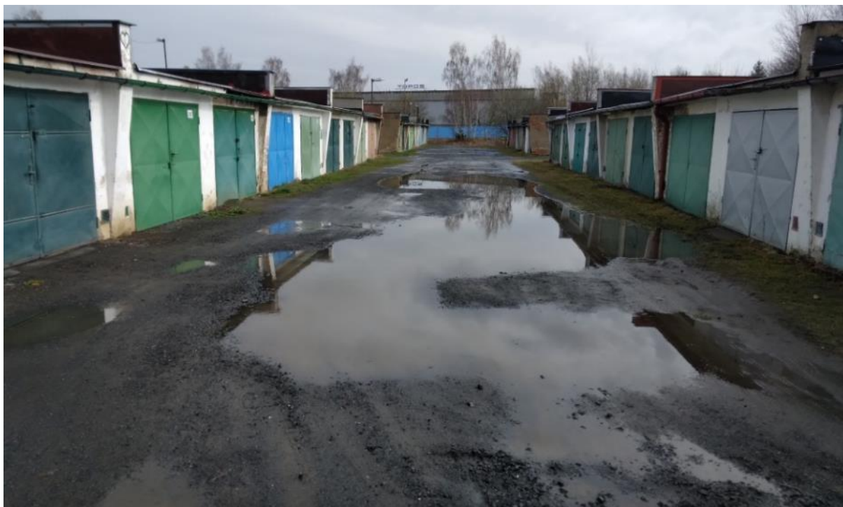
Původní běžný stav na garážích po dešti
