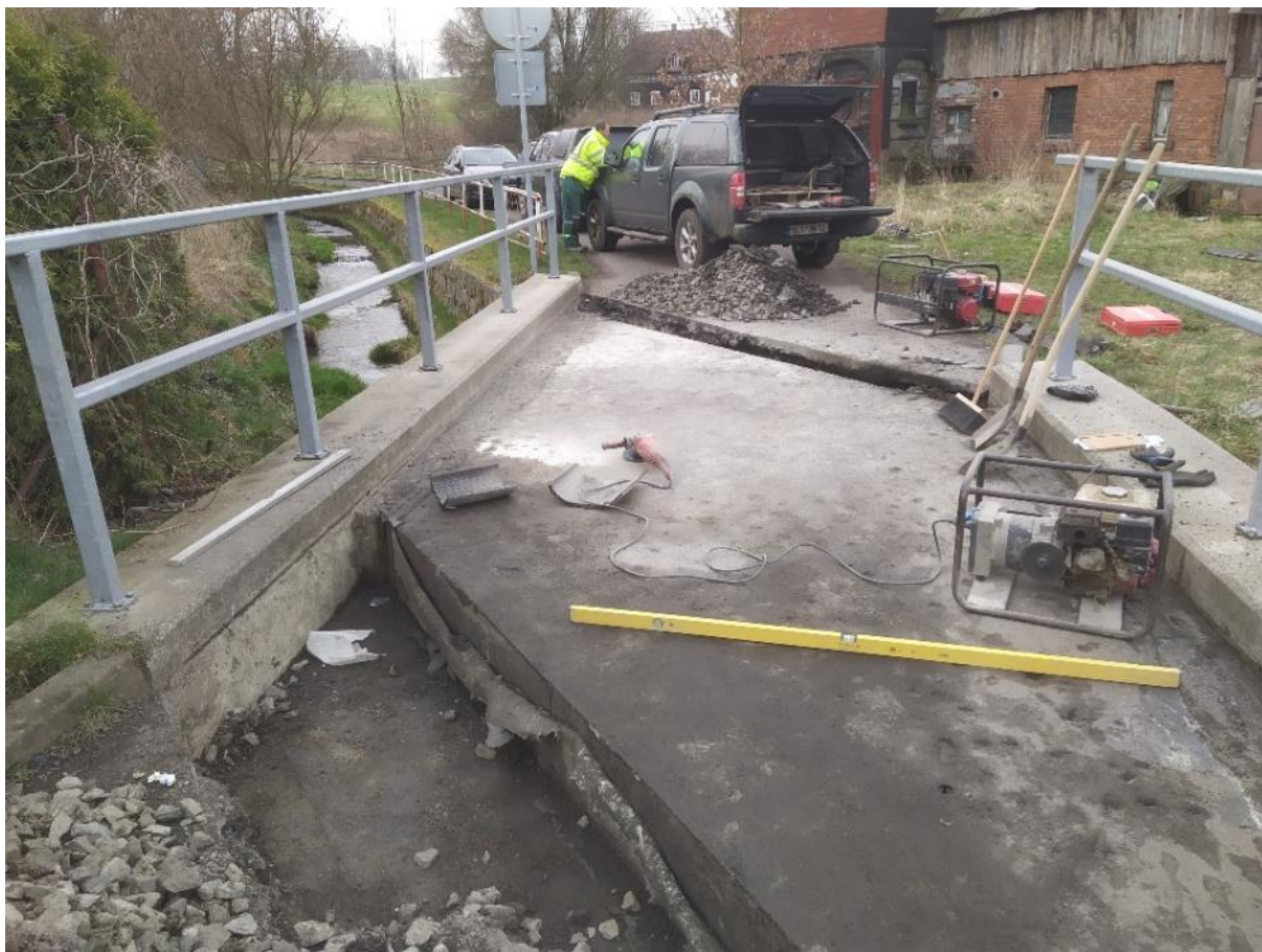
oprava hydroizolace mostu v Království
