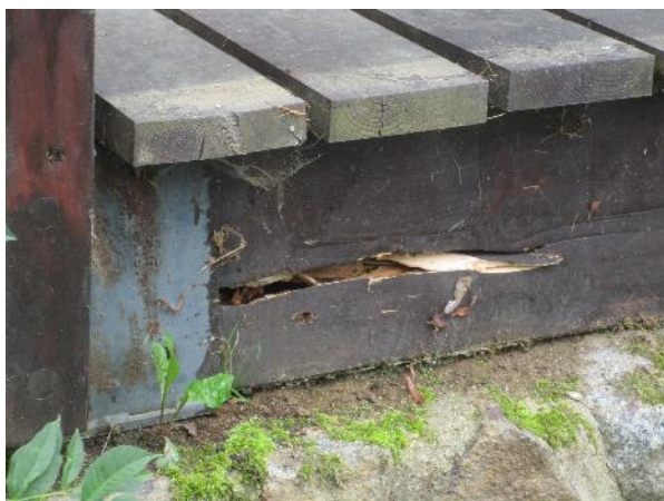
vyhnílé nosné trávy původní lávky
