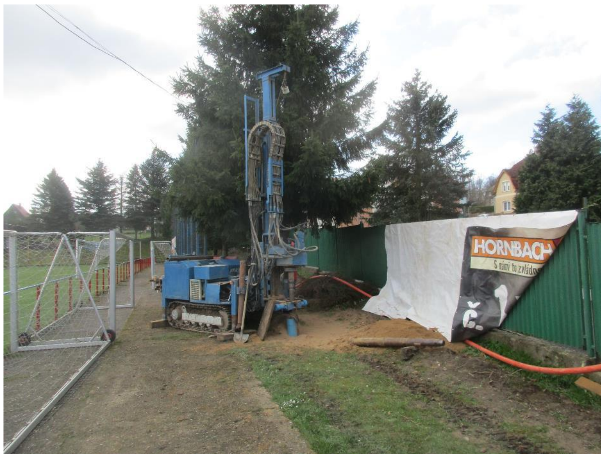
vrtání nového průzkumného vrtu
