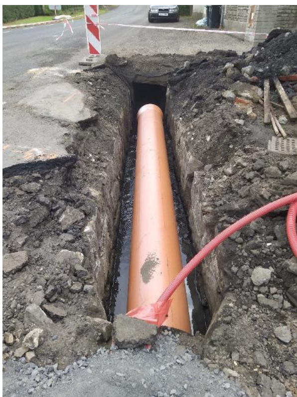
zatrubnění potoka pod trasou chodníku
