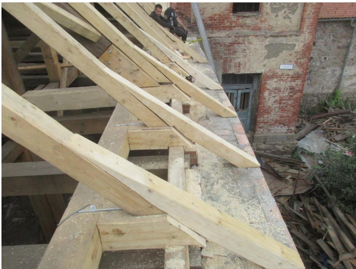
nová pozednice, krokve a námětky severního průčelí
