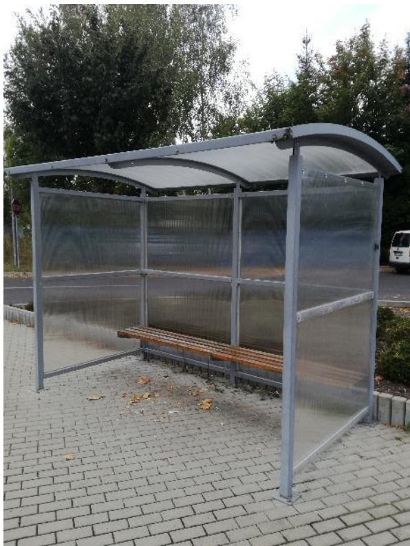
zasklení zastávky Benar
