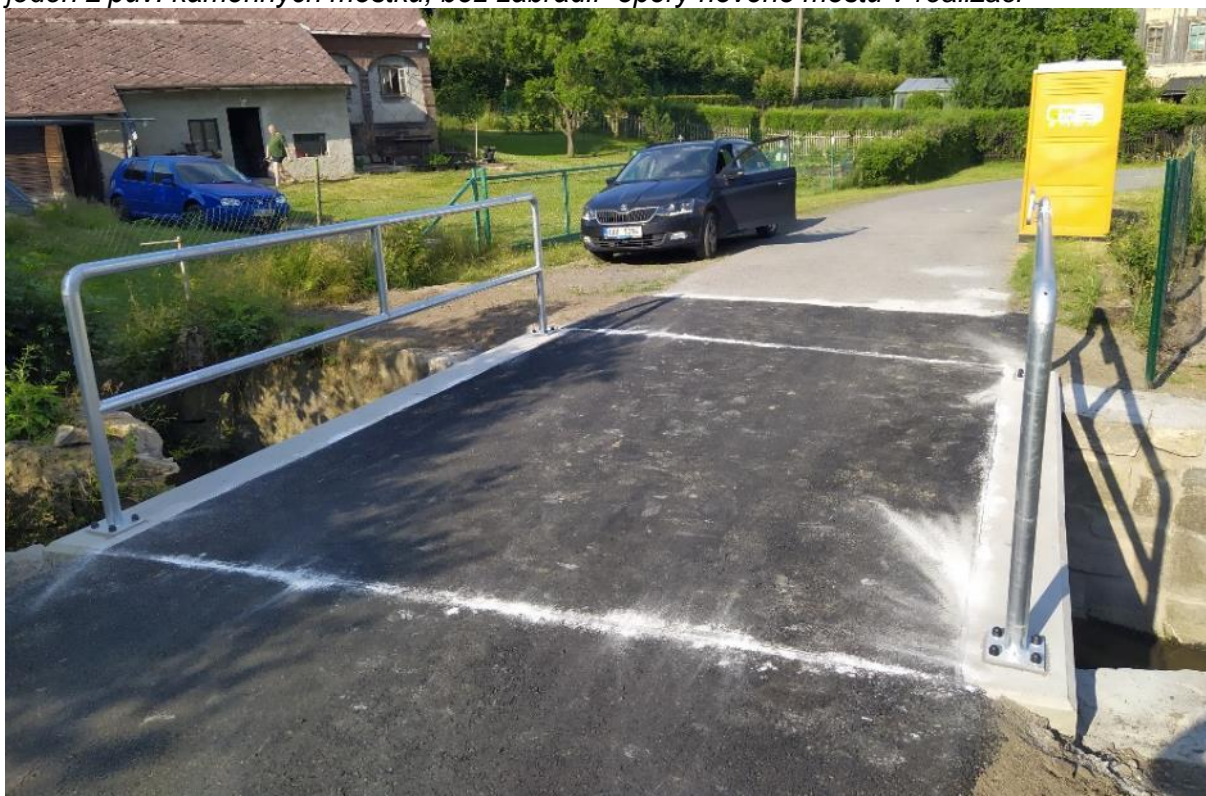
Dokončený most za TS
