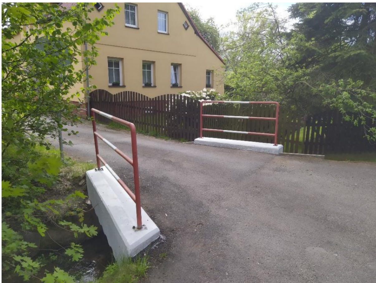
obnovené římsy mostu v Císařském
